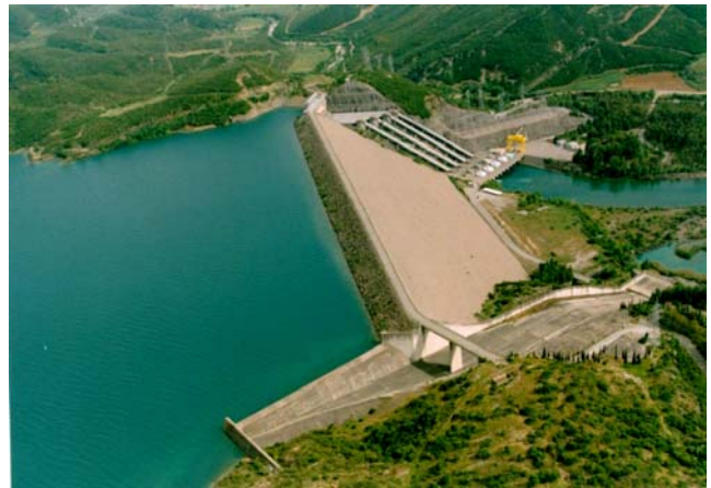
Το φράγμα Καστρακίου
